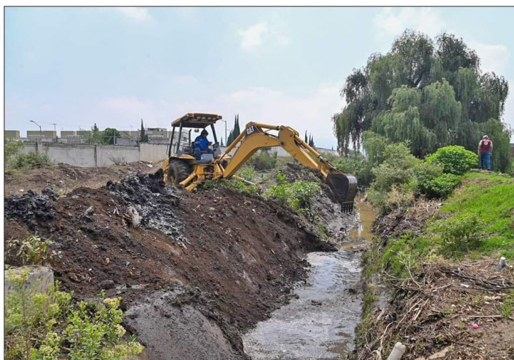
▲ Con maquinaria pesada desazolvan los cauces de ríos y canales para evitar su desbordamiento. Foto especial
