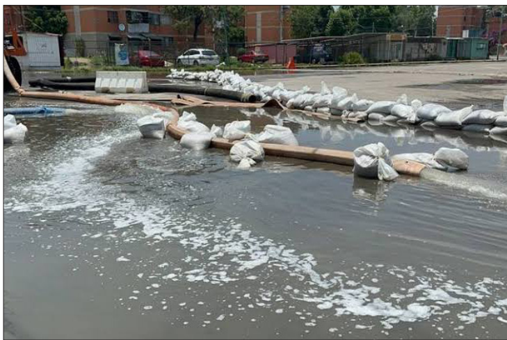
▲ Ante las intensas lluvias registradas en la Presa El Ángulo colocan 2 mil costales. Foto especial
