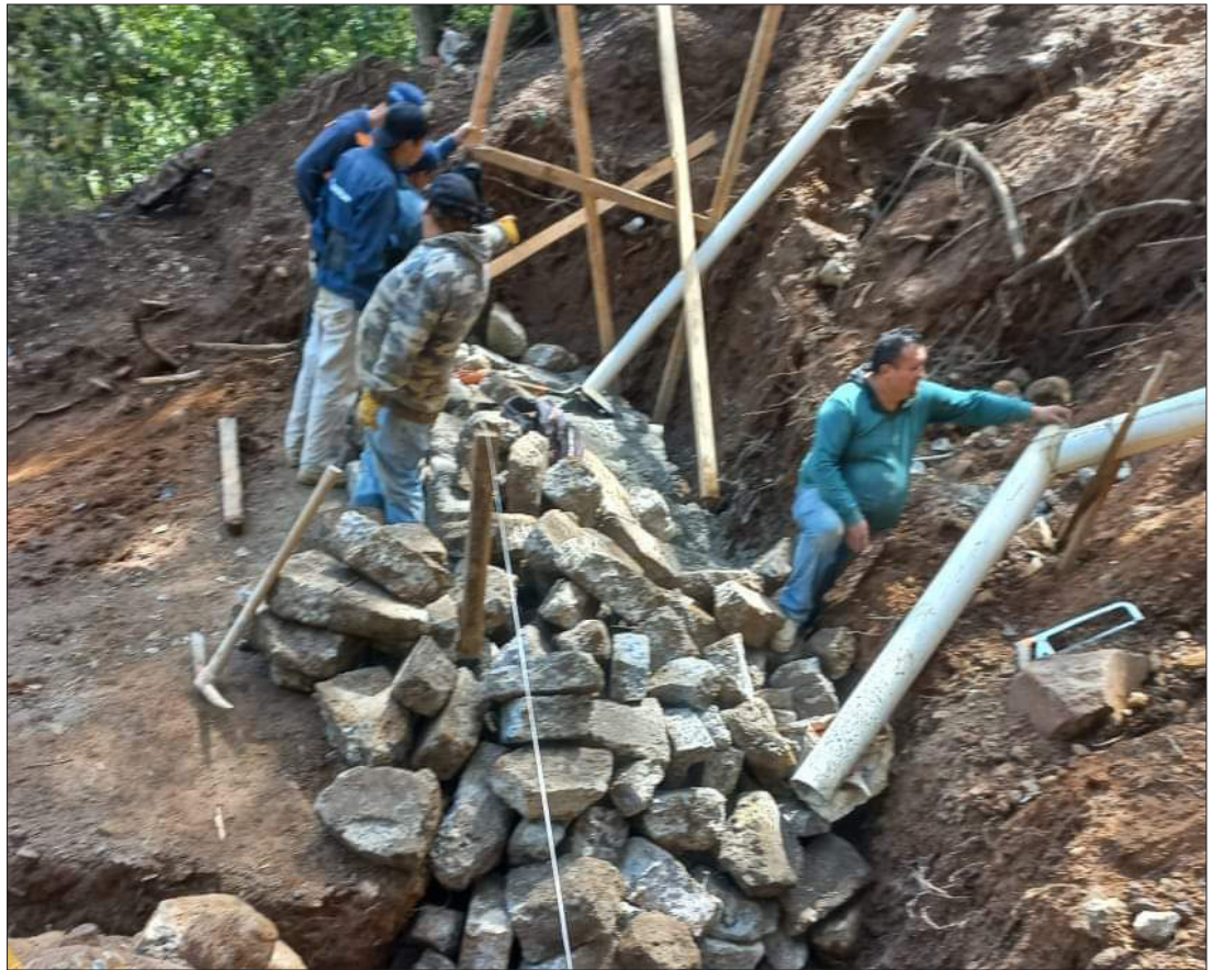
▲ En algunos puntos se han retirado hasta 5 mil metros cúbicos de material rocoso, principalmente en vialidades montañosas. Foto especial
